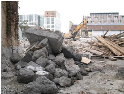
Photo 1 : Blocs de béton de mâchefer banché sur un chantier de démolition à Lyon Gerland (photo CAUE Rhône Métropole)
