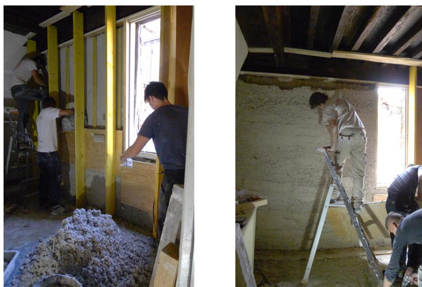
Figure 9 : Mise en œuvre du chaux-chaux banché avec les élèves de la Chambre des Métiers du Lot dans les appartements tests du projet ENERPAT, septembre 2017
