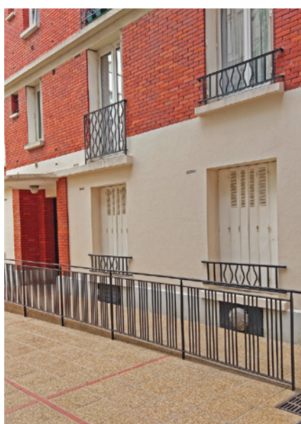
Aménagement d'une rampe PMR permettant d'accéder aux parties communes de l'immeuble. Installation d'un garde-corps en soutien de la rampe. Groupe Rataud (Paris 5 e ) – Elogie-SIEMP
