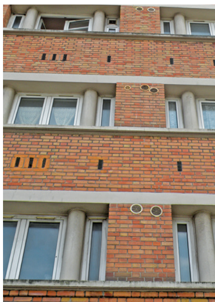
Superposition de différentes générations de ventilations face aux problèmes récurrents de l'humidité dans les logements.
