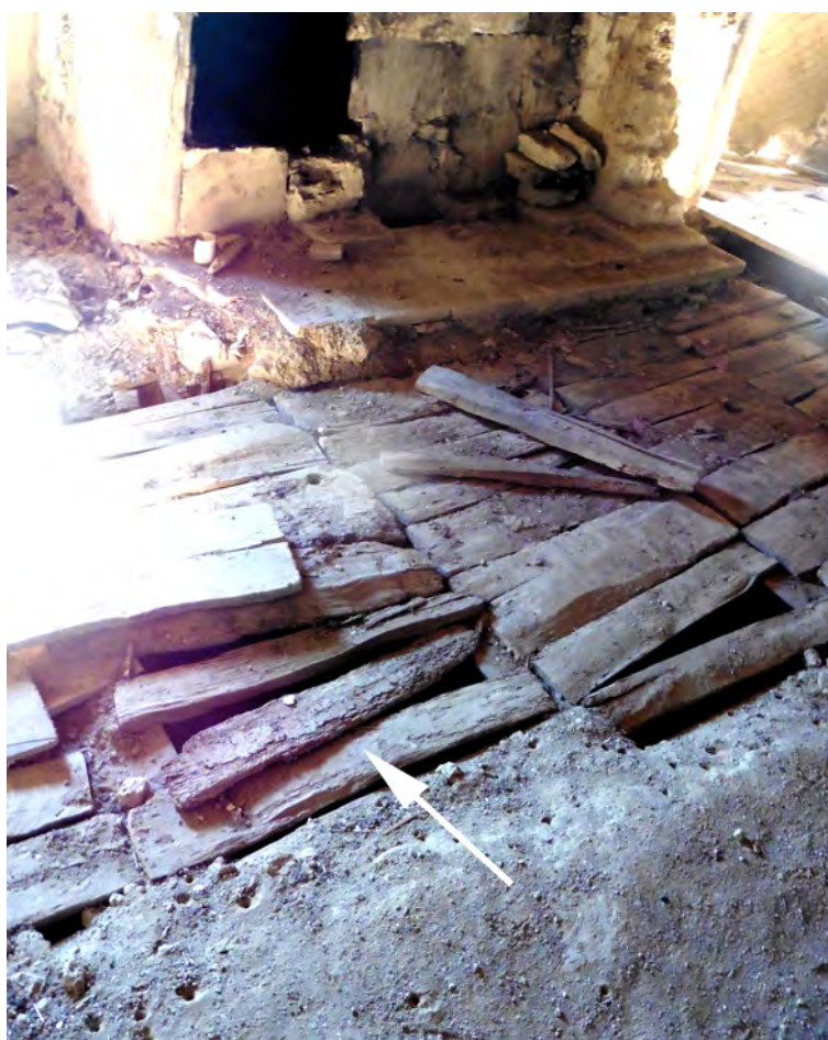
Illustration 3: Plancher de palets, support d'une chape de torchis, vu par dessus (Gers). (Sophie Popot)
