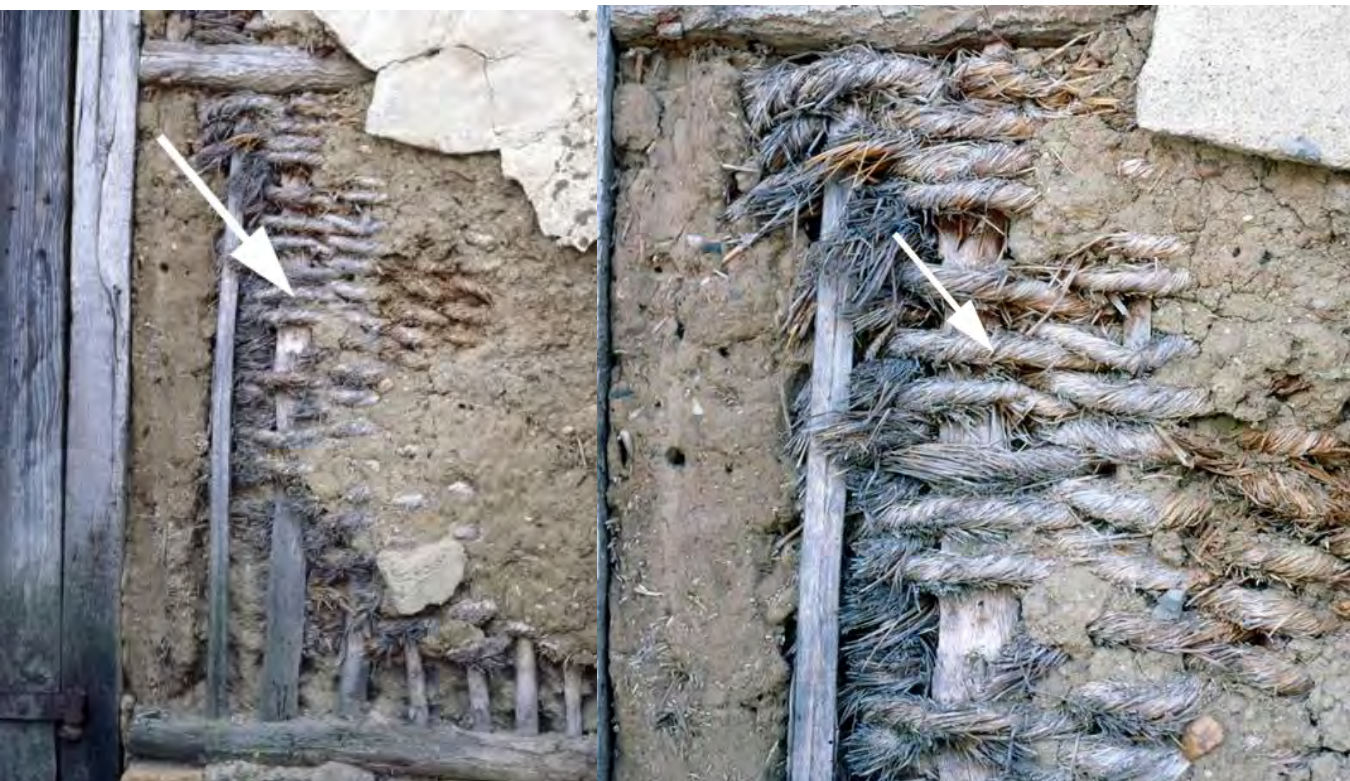
Illustration 20: Détail. La paille est torsadée directement ou après trempage dans une barbotine de terre, puis elle est tressée sur la
