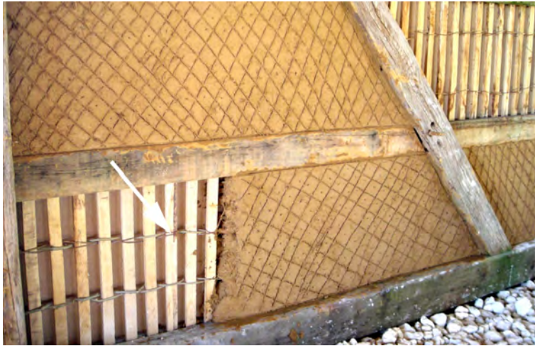
Illustration 19: un clayonnage composé de palaçons verticaux en première trame et de liens d'osier en deuxième trame (Aurélie Le Pape)
