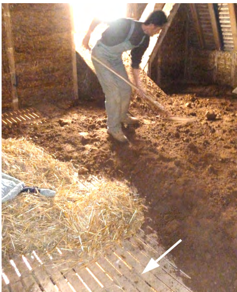
Illustration 26: un lattis au sol formant plancher non jointif, vu de dessus. Avant la pose de la chape sèche (Sophie Popot)
