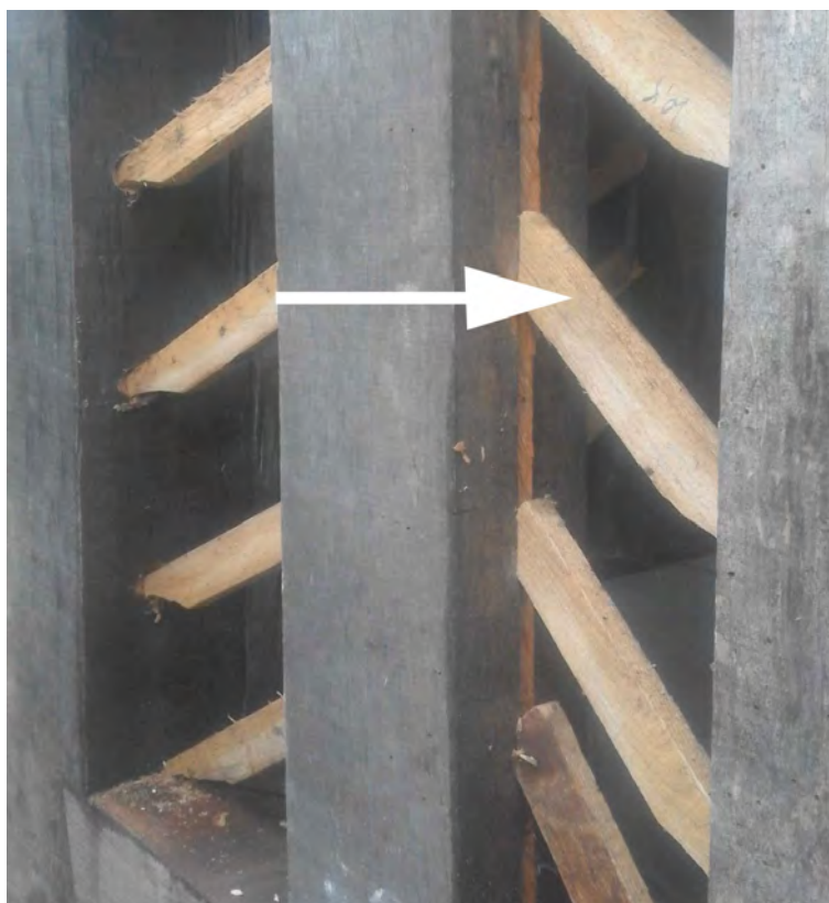
Illustration 11: une éclisse entre deux colombes de trame étroite avant la pose du mélange. (Yan Minne)
