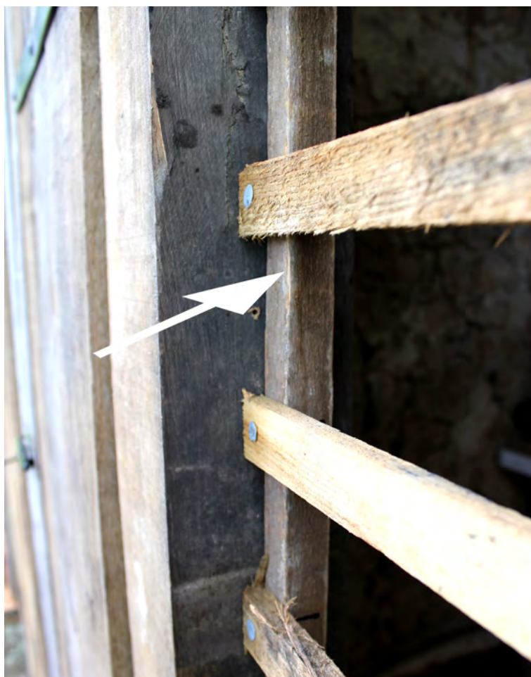
Illustration 13: Contre-latte visible avant la pose du mélange Normandie (Yan Minne)
