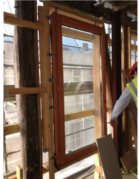
Pose d'une fenêtre © F+L architectes
