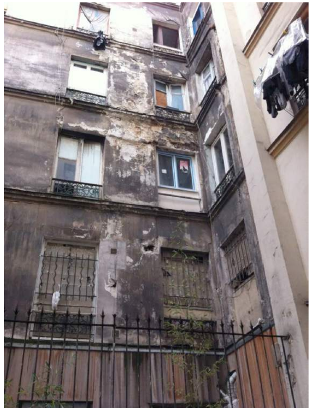
État initial - façade sur cour © F+L architectes
