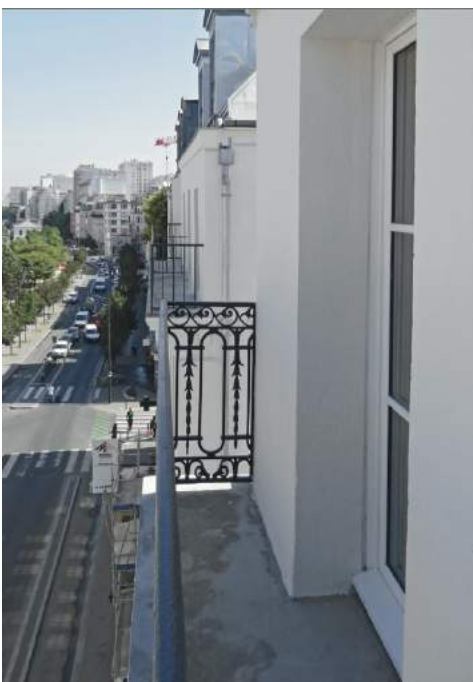
Balcon sur rue d'Aubervilliers © F+L architectes
