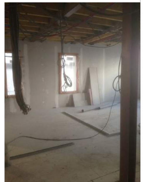
Finition intérieure : plaques de BA13 © F+L architectes
