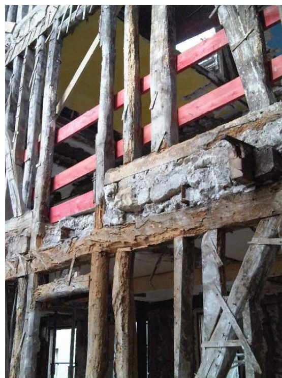
Étape du curetage des pans de bois © F+L architectes
