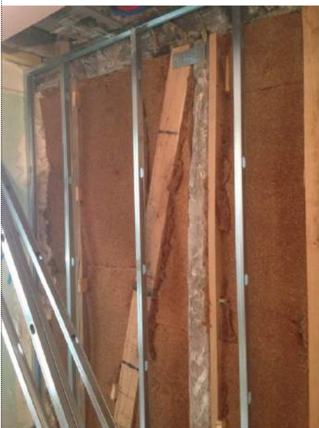
Isolant en fibres de bois © F+L architectes
