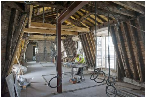
Réfection des combles © Jean-Claude Pattacini pour la Siemp
