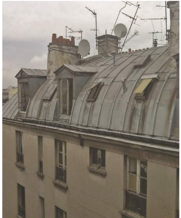
État initial - toiture cintrée du 1 passage Goix © F+L architectes
