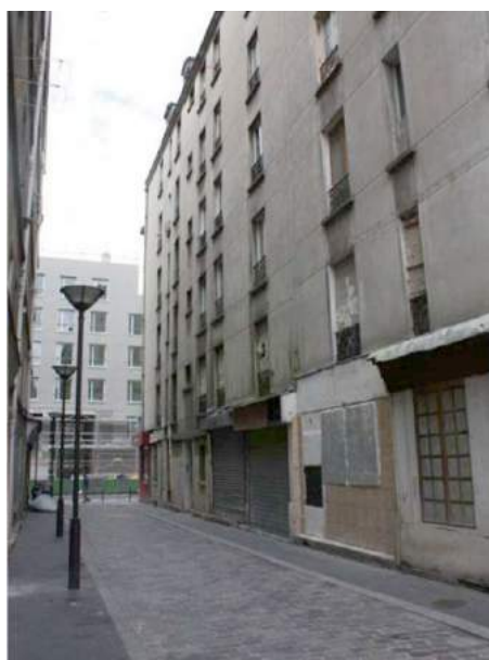
État initial de la façade du 2 passage Goix © F+L architectes
