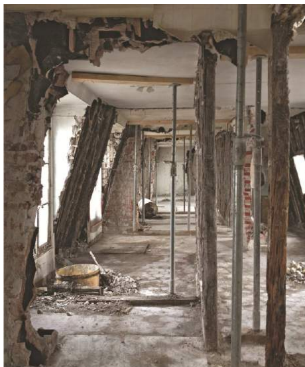
Étape du curetage des pans de bois © F+L architectes
