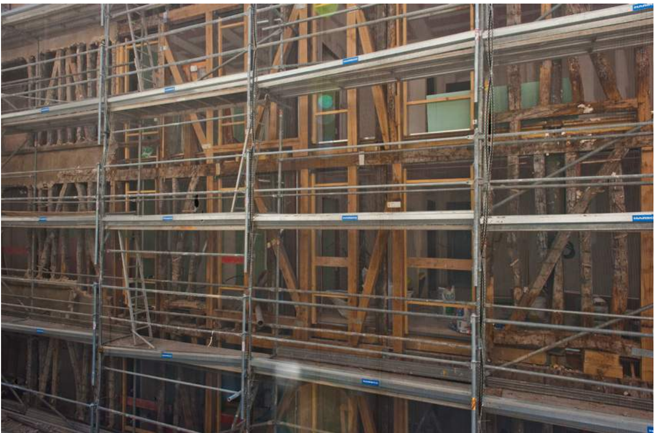
Vue des travaux en façade © Jean-Claude Pattacini pour la Siemp
