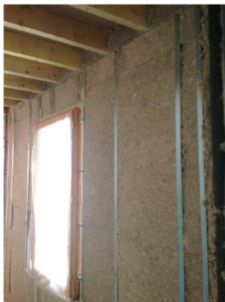
Isolant en chanvre © F+L architectes
