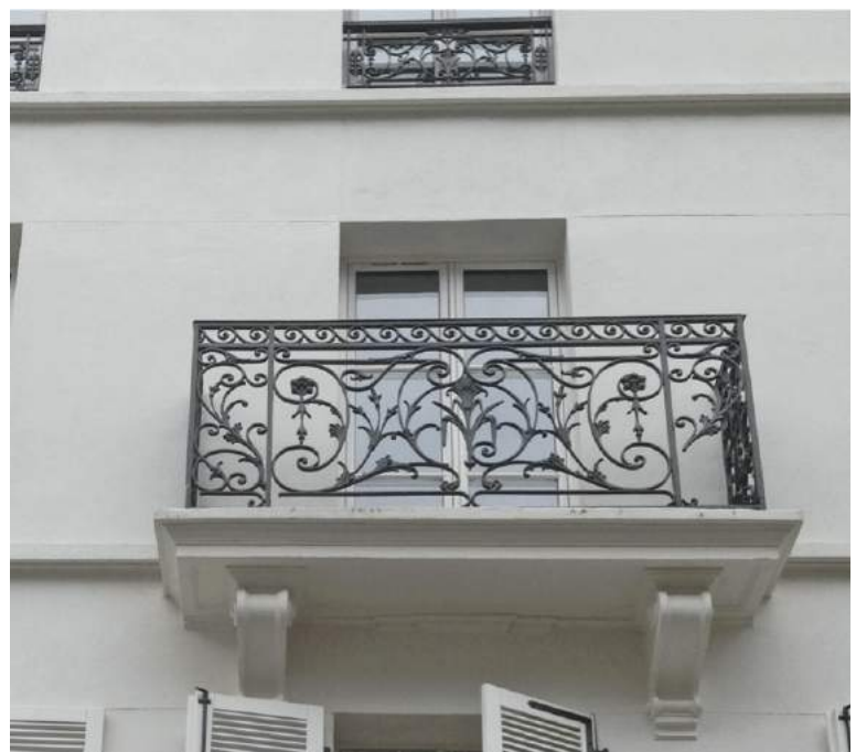
Balcon sur rue d'Aubervilliers © F+L architectes
