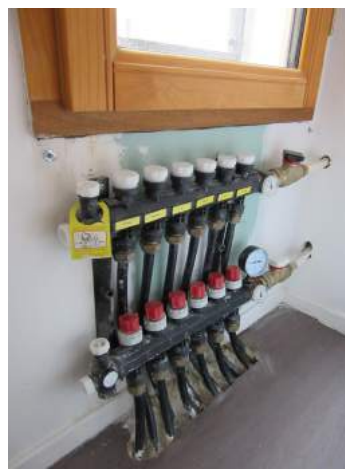
Système de régulation du plancher chauffant © Ekopolis
