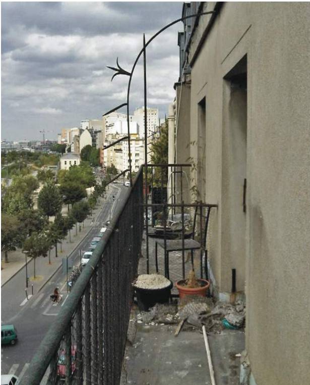
État initial - balcon de la façade principale © F+L architectes
