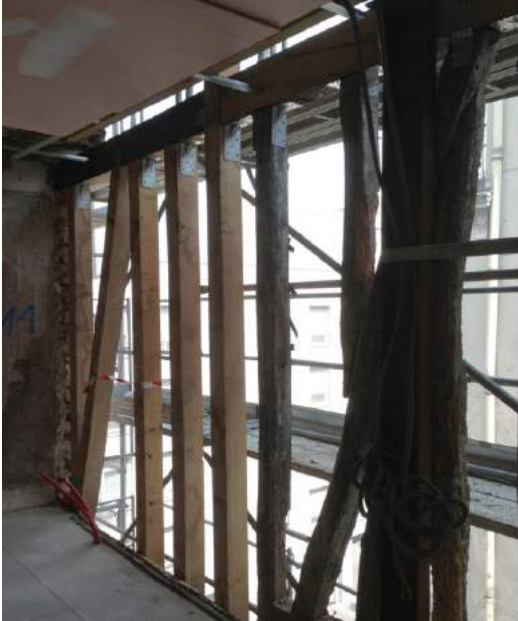
Remplacement des éléments en bois endomagés © F+L architectes
