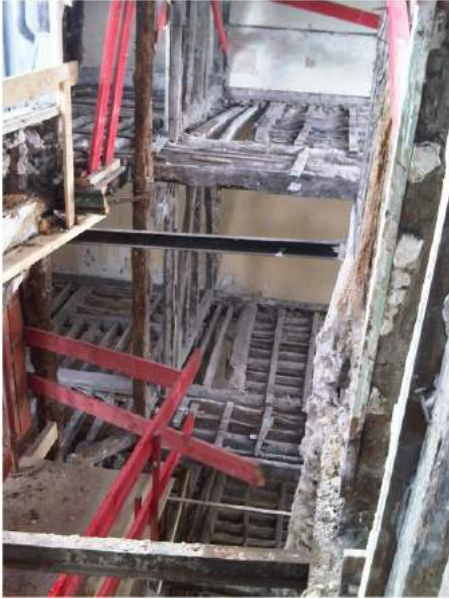
Travaux sur planchers existants © F+L architectes
