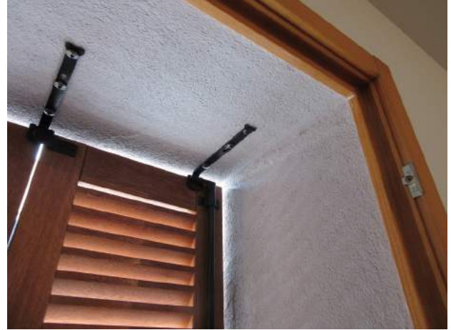
Détail de fixation d'un volet © Ekopolis
