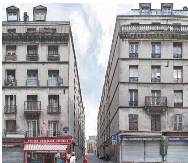
État initial vu depuis la rue d'Aubervilliers © F+L architectes
