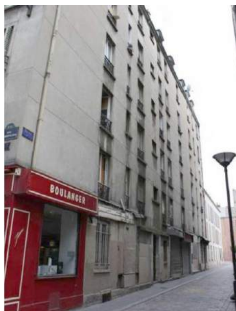
État initial de la façade du 1 passage Goix © F+L architectes
