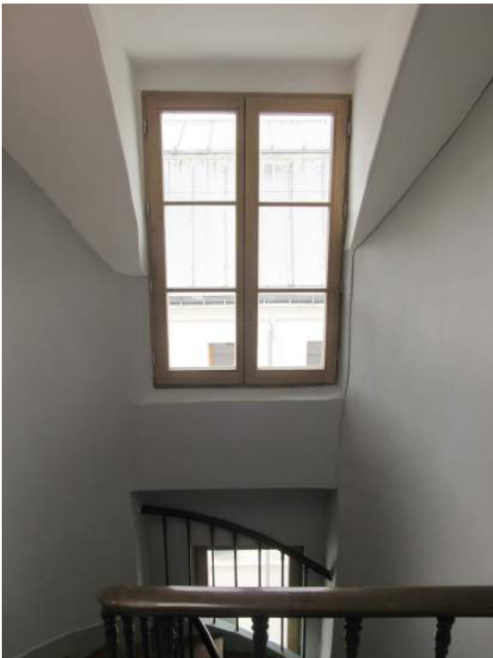
Communs - cage d'escalier © Ekopolis
