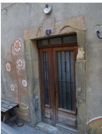
Essais d'enduits à chaux sur la façade pour vérifier la tenue des couleurs et de la matière en attendant que le mur puisse être assaini.
