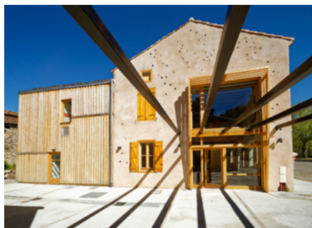
Façade Sud : l'extension en bois, la baie vitrée créée avec le brise-soleil en bois
