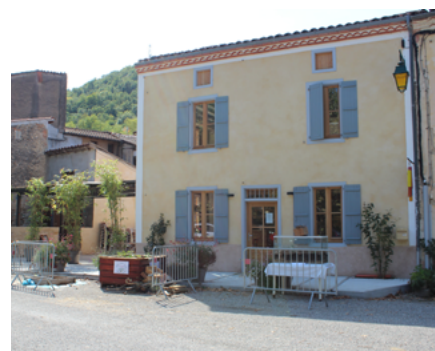
Façade Est : réfection des menuiseries à l'identique
