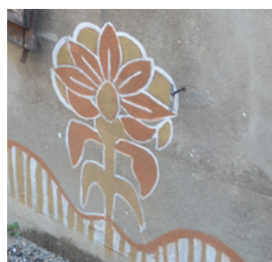
Essais d'enduits à chaux sur la façade pour vérifier la tenue des couleurs et de la matière en attendant que le mur puisse être assaini.
