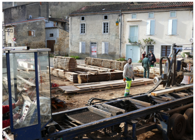
Installation de la scierie mobile devant l'Estanquet
