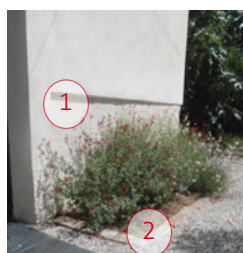
Traitement du pied de mur
