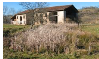
La mare présente au Sud-Est du bâtiment
