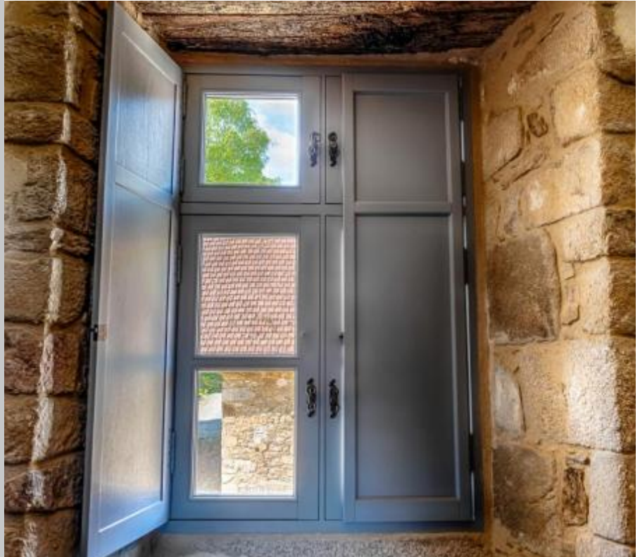
Menuiserie neuve réalisée à l'identique de la fenêtre d'origine, en conservant les petits bois, l'imposte et les volets intérieurs.
