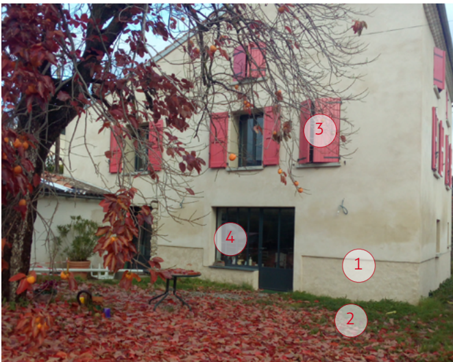
Façade sud, après travaux
