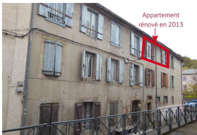
Vue du bâtiment avant les travaux
