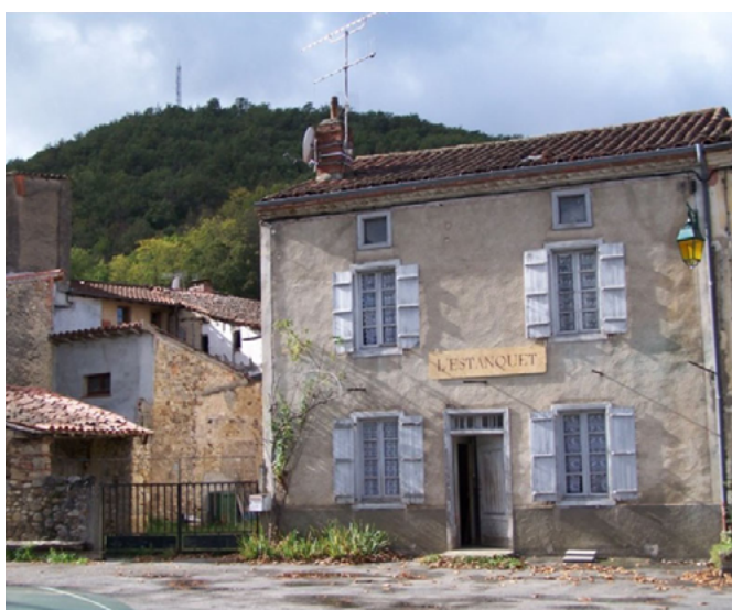
Vue du bâtiment avant les travaux
