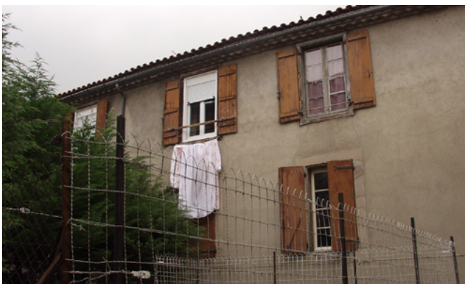
Fenêtre et volets en PVC sur l'appartement rénové
