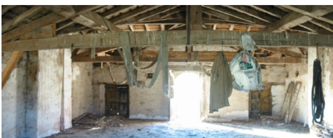
Charpente en bois
