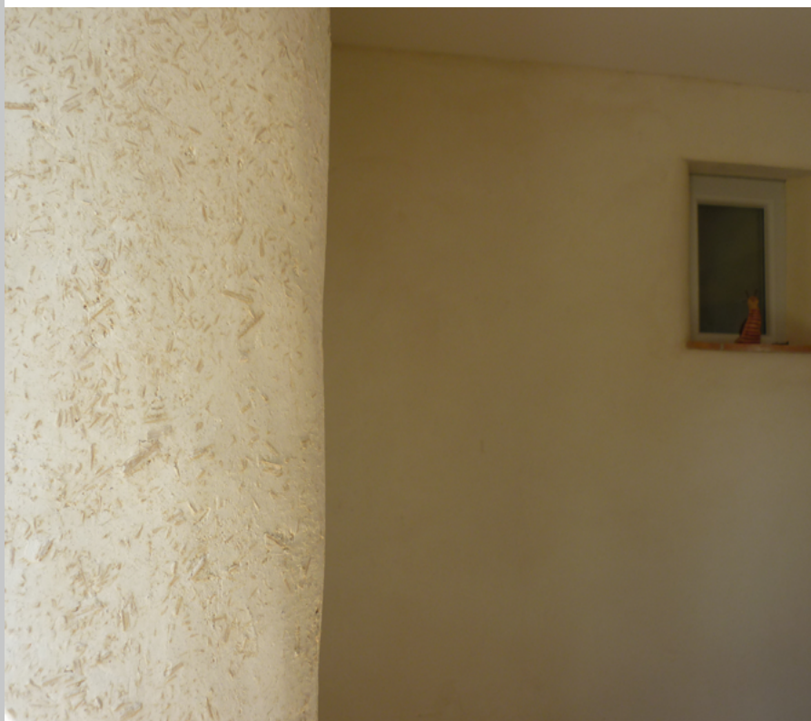
Enduit chaux-chanvre sur un mur intérieur
