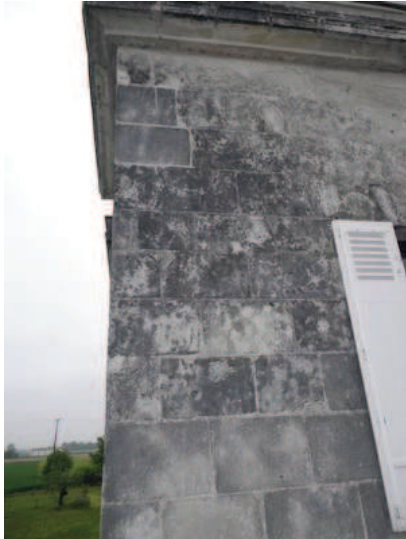
Fig. 1.14 : Croûte noire – Bâtiment n°3 (Source : auteure)
