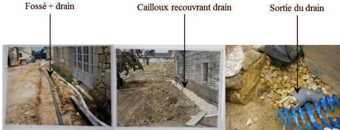
Fig. 2.4 : Étapes de la mise en place du drain extérieur
