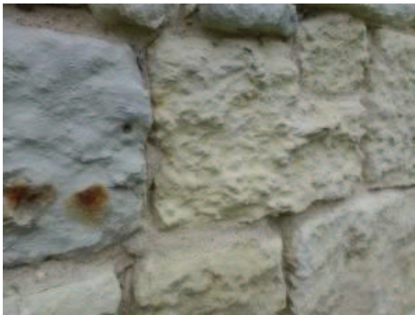
Fig. 1.15 : Alvéolisations – Bâtiment n°18 (Source : auteure)
