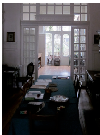
Baie de communication entre la pièce de réception et la salle à manger. Permet de séparer voire de condamner partiellement un espace habitable l'hiver.
