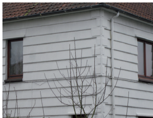
Chantier expérimental (1921) : zone qui pourrait retrouver sa vocation avec des techniques d'économies d'énergie
