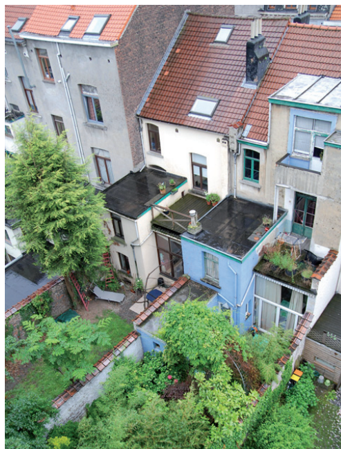
LES ANNEXES : UN DÉVELOPPEMENT ERRATIQUE DES BÂTIMENTS PAR L'ARRIÈRE
