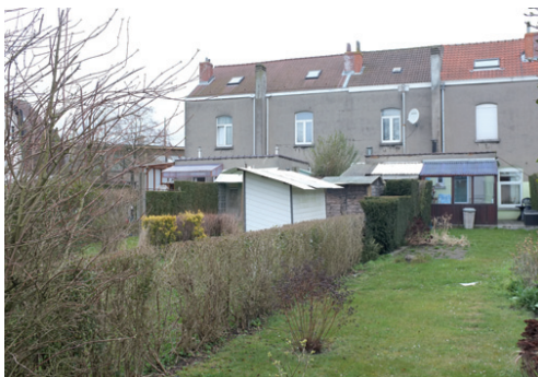
Extensions en façades arrières sur les jardins
