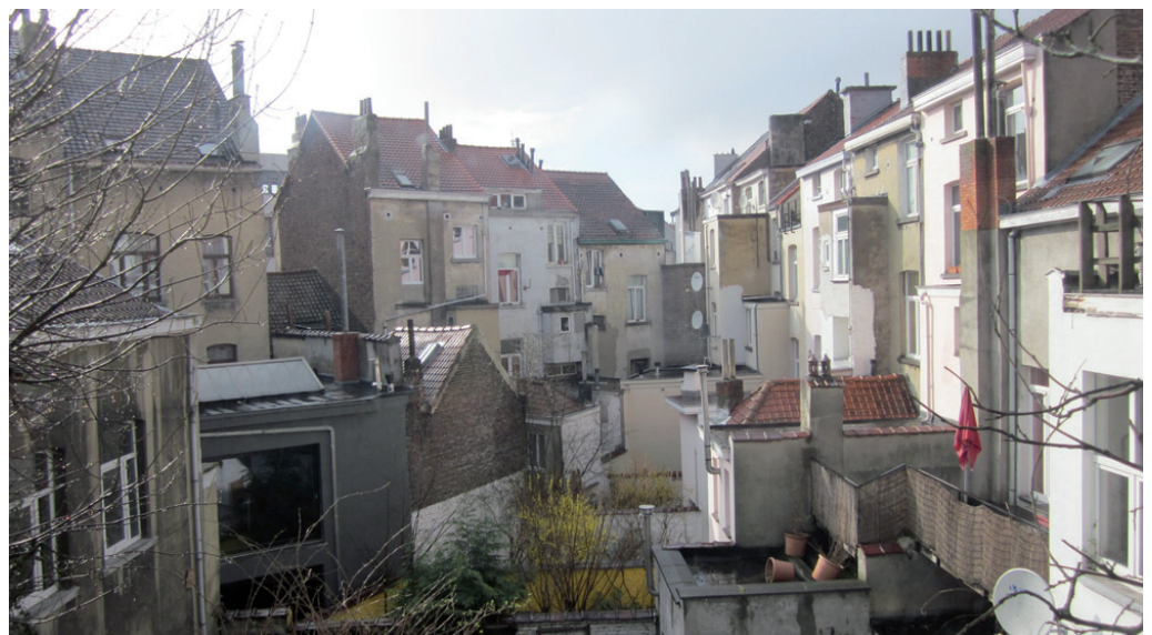
Cœur d'îlot montrant le développement des annexes. L'isolation extérieure peut être appliquée sans précaution particulière.
