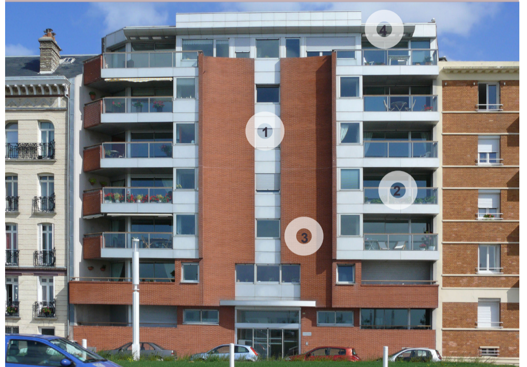
1• façade composée 2• larges menuiseries métalliques, 3• panneaux de brique de parement, 4• toit terrasse
