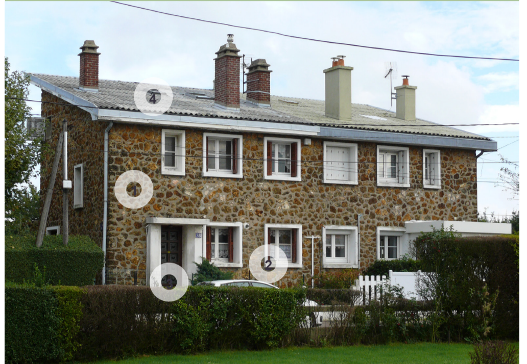
1• pierre de meulière, 2. bloc-baie avec encadrement ciment, 3• porte d'entrée en bois ouvragée, 4. toiture monopente en fibrociment
