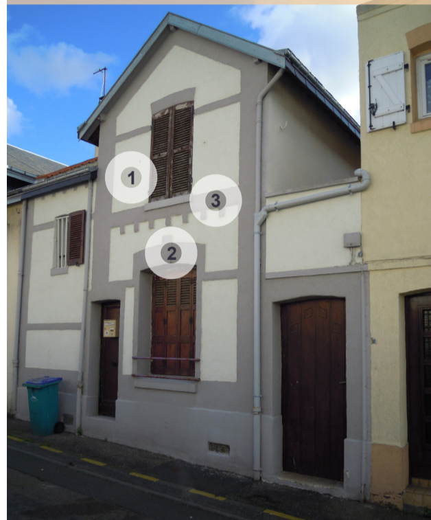
1• brique apparente, enduite ou peinte 2• linteau cintré 3• modénatures
