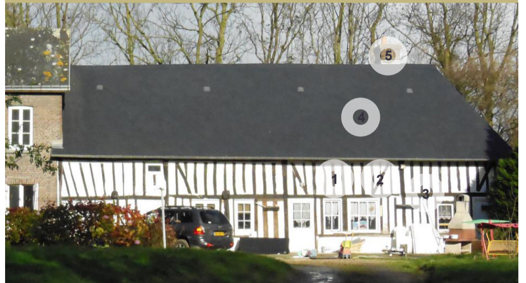
1• pan de bois à colombage, 2• écharpe de contreventement, 3• sablière intermédiaire servant de linteau aux ouvertures, 4• pente de toit prononcée, 5• souche de cheminée maçonnée
