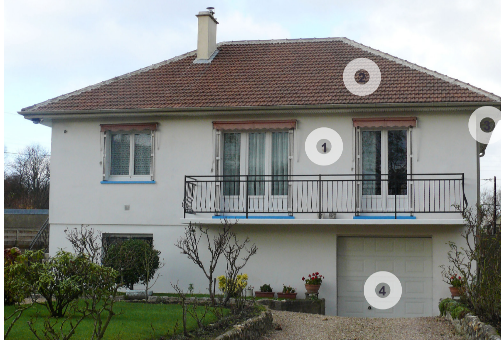
1• façade porteuse en maçonnerie de parpaing enduit, 2• toiture à quatre pans, 3• débord de toit important, 4• garage en rez-de-chaussée
