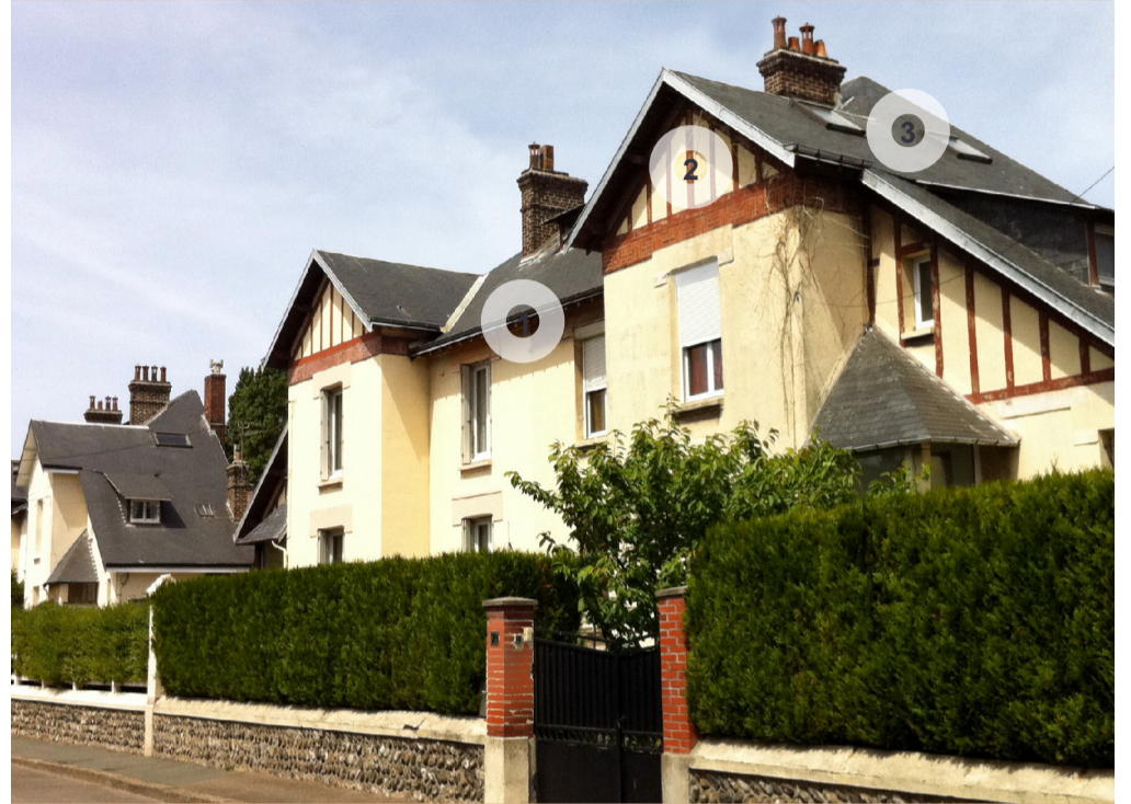
1• composition symétrique, 2• faux-colombage, 3• toiture généreuse
