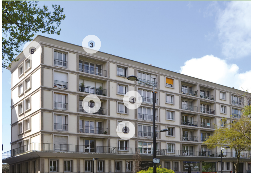
1• lisibilité de la structure verticale et horizontale, 2• encadrement de fenêtre en saillie, 3• toiture-terrasse, 4• loggia, 5• corniche
