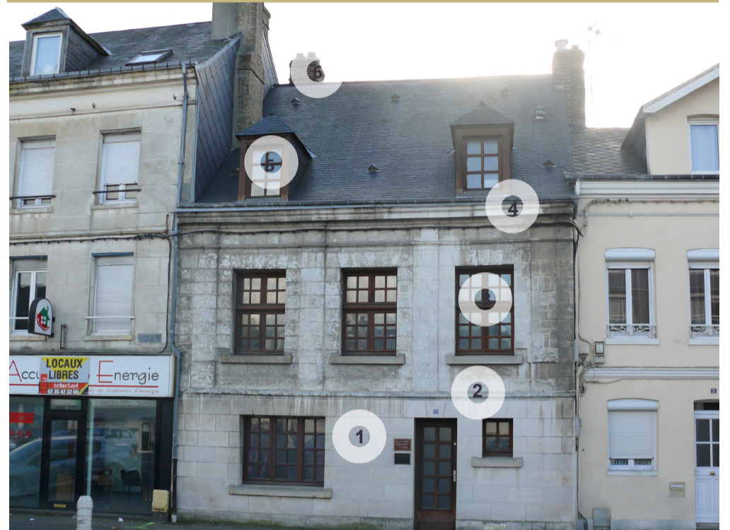
1• mur en maçonnerie de pierre de taille, 2• bandeau, 3• fenêtre à meneaux, 4• corniche, 5• lucarne capucine, 6• souche de cheminée
