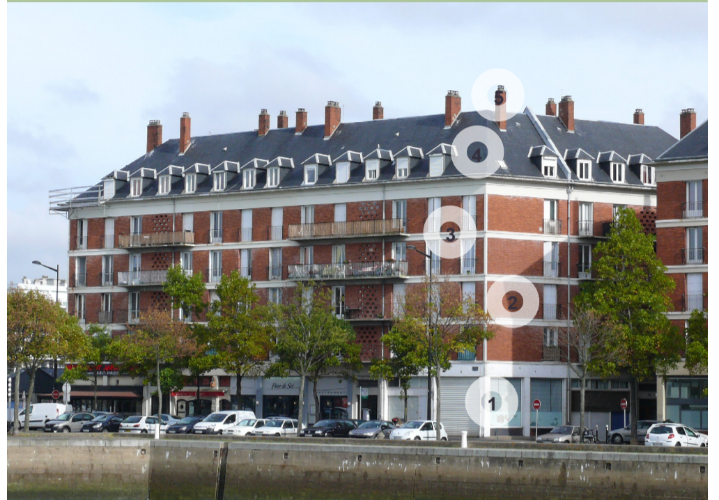
1• rez-de-chaussée en béton avec commerces, 2• murs de façade en brique, 3• nez de plancher en béton visible, 4• comble habité, 5• conduits de cheminée en brique
