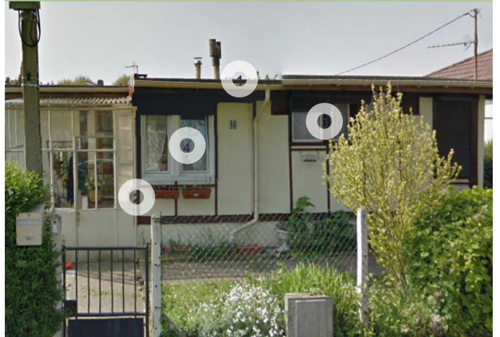
1• toiture à faible pente, 2• structure bois encore parfois visible en façade, 3• bandeau de fenêtre à l'origine, 4• fenêtres d'angle
