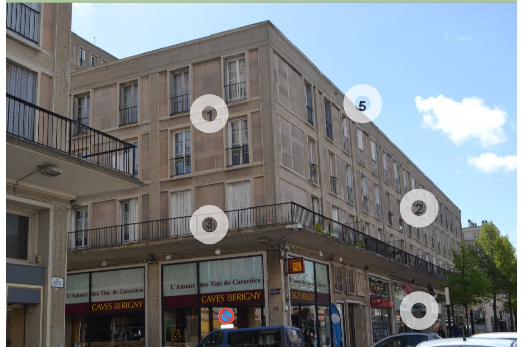
1• visibilité de la structure porteuse, 2• rythme des ouvertures, 3• balcon filant, 4• galerie sur deux niveaux, 5• toiture-terrasse avec corniche
