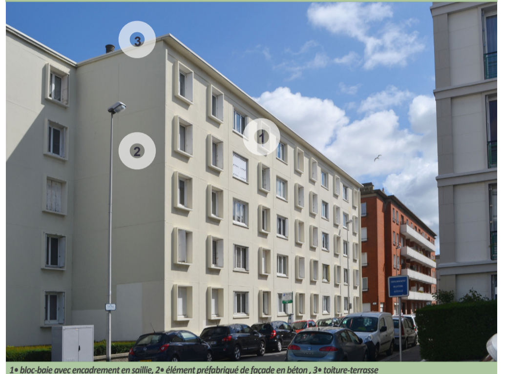
1• bloc-baie avec encadrement en saillie, 2• élément préfabriqué de façade en béton, 3• toiture-terrasse
