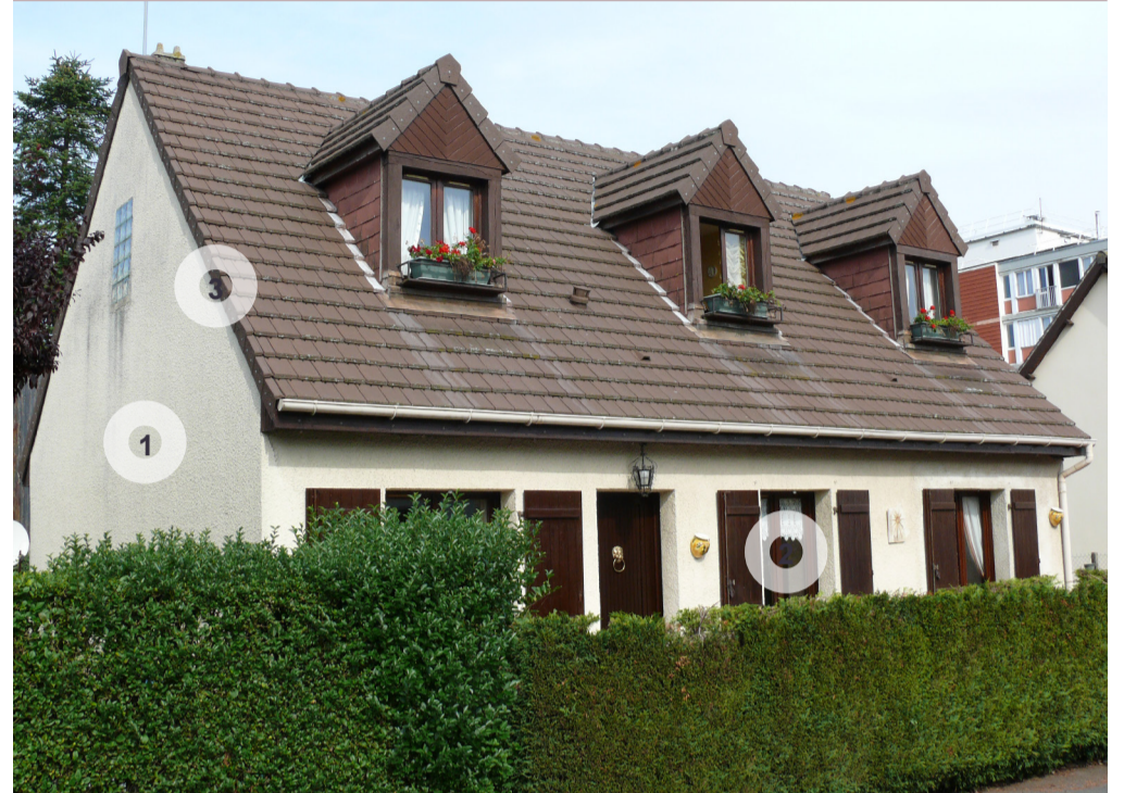
1• façade porteuse en parpaing enduit, 2• surfaces vitrées limitées, 3• peu de débord de toit
