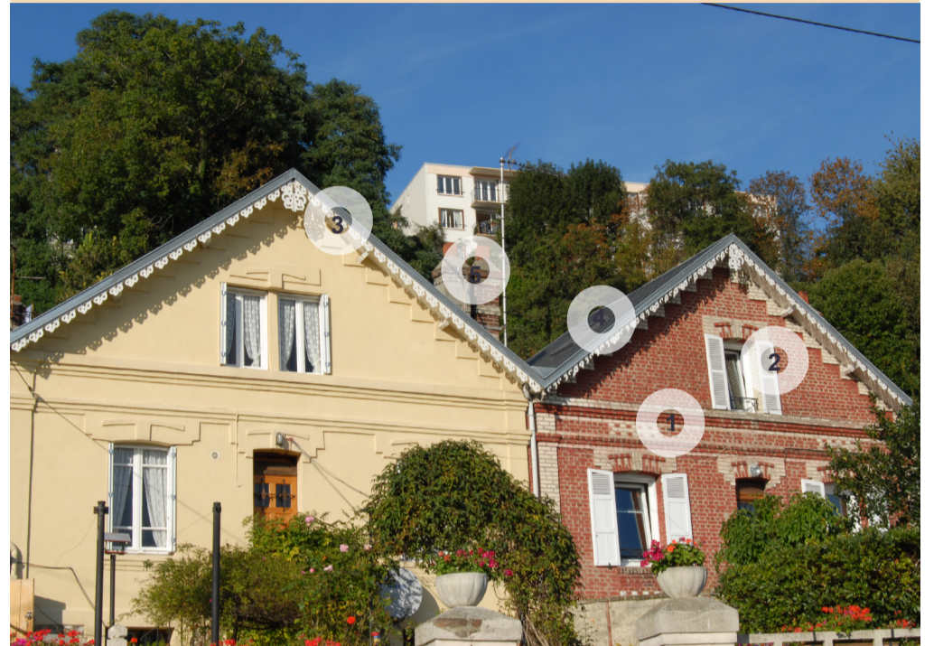
1• maçonnerie en brique avec éléments de modénature, 2• volet ou persienne à battant, 3• lambrequin en bois peint, 4• toiture à deux rampants, 5• conduits de cheminée
