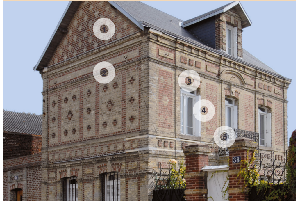
1• brique apparente avec bichromie jaune/rouge, 2• bandeau périphérique, 3• linteau cintré, 4• encadrement des baies, 5• balustre en fer forgé
