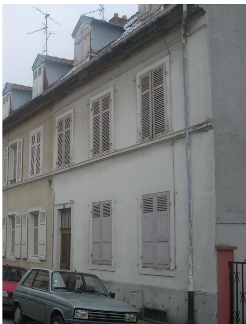
Bâtiment du 19 rue des Vosges
