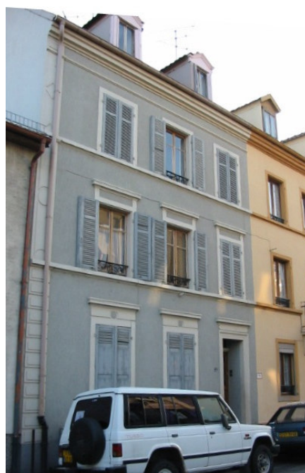
Bâtiment du 31 rue des Vosges
