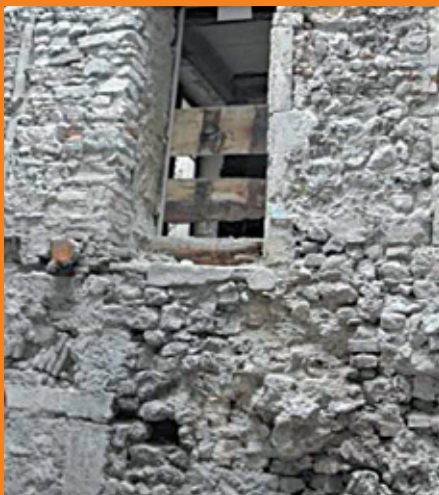
Mur traditionnel en cours de restauration
