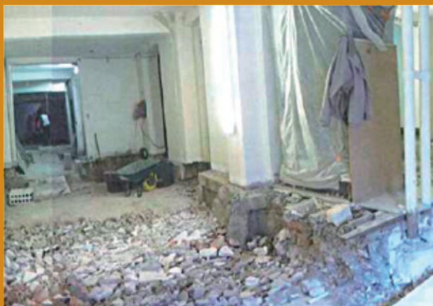
Reconstruction de la dalle.
