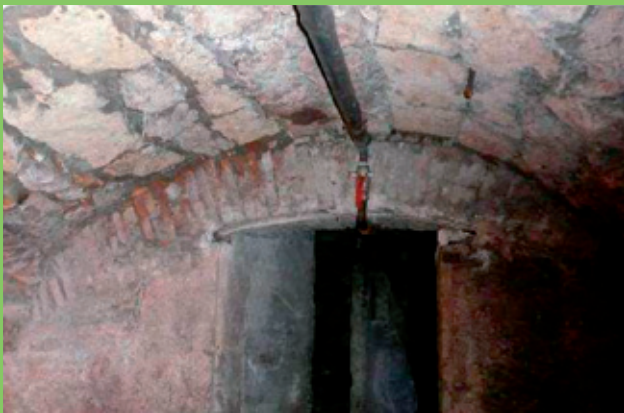
Voûte en pierre
